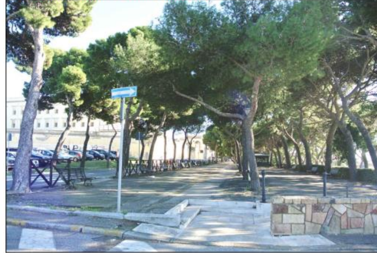
Punto di presa n.4 - Ante intervento
