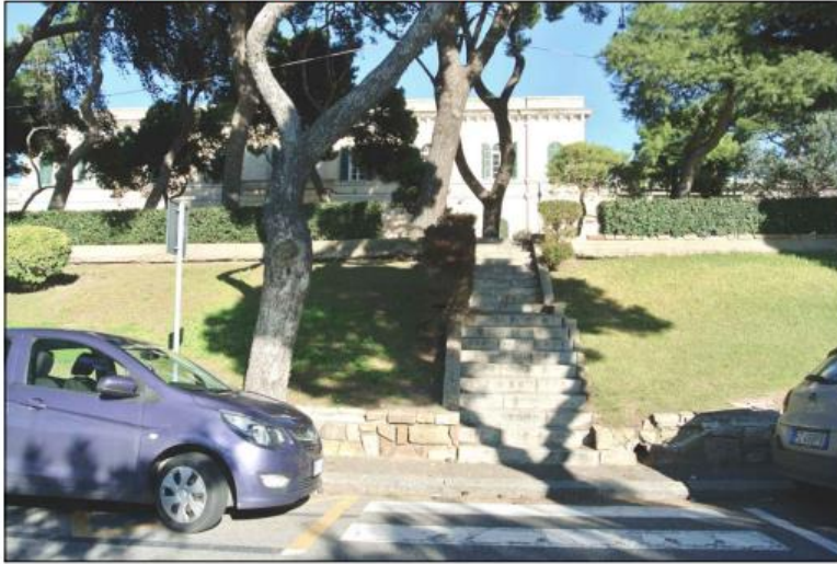
Punto di presa n.7 - Ante intervento
