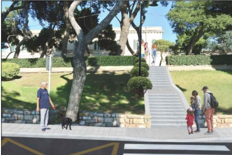
Punto di presa n.7 - Post intervento
